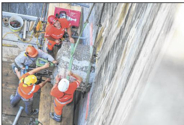
Les carottes extraites du béton sont emportées, sans même toucher l'échafaudage, haut de 20 mètres.
