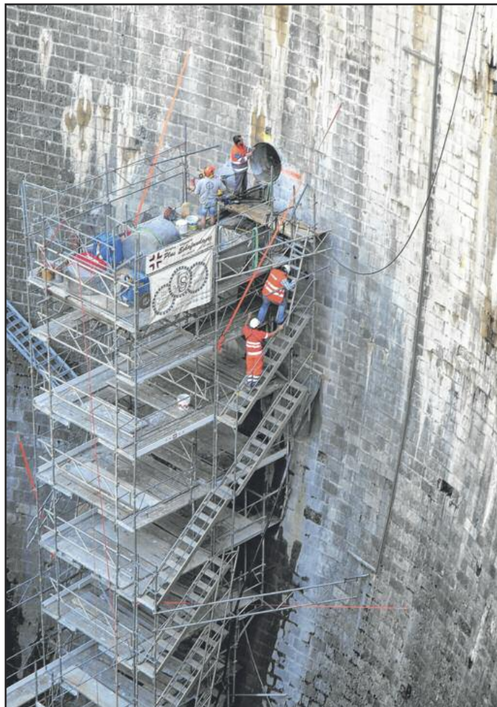
Les carottes extraites du béton sont emportées, sans même toucher l'échafaudage, haut de 20 mètres.
